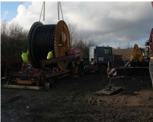
4. Trekken van de kabels
