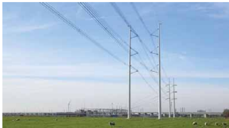
Voorbeeld van bi-pole masten in een open landschap Bron: http://www.hoogspanningsnet.com/
