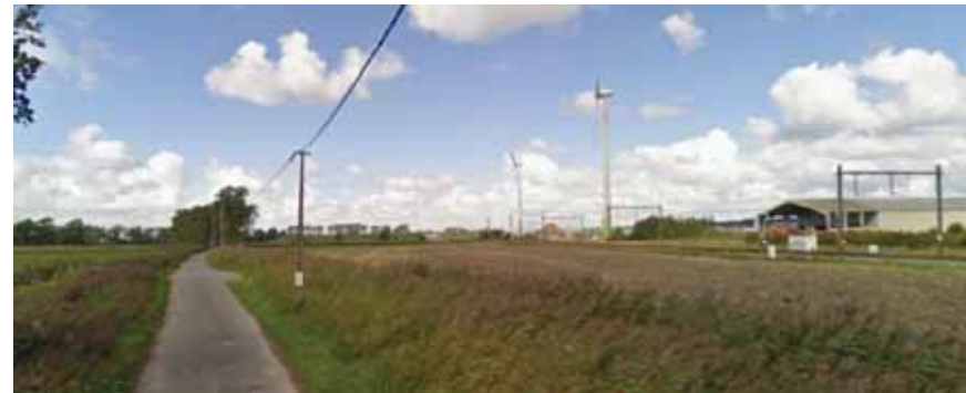
Zicht vanaf Lentestraat (ten noorden van bestaande bebouwing) naar projectgebied
