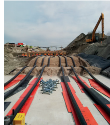
Ondergrondse 380 kV-kabelverbinding
