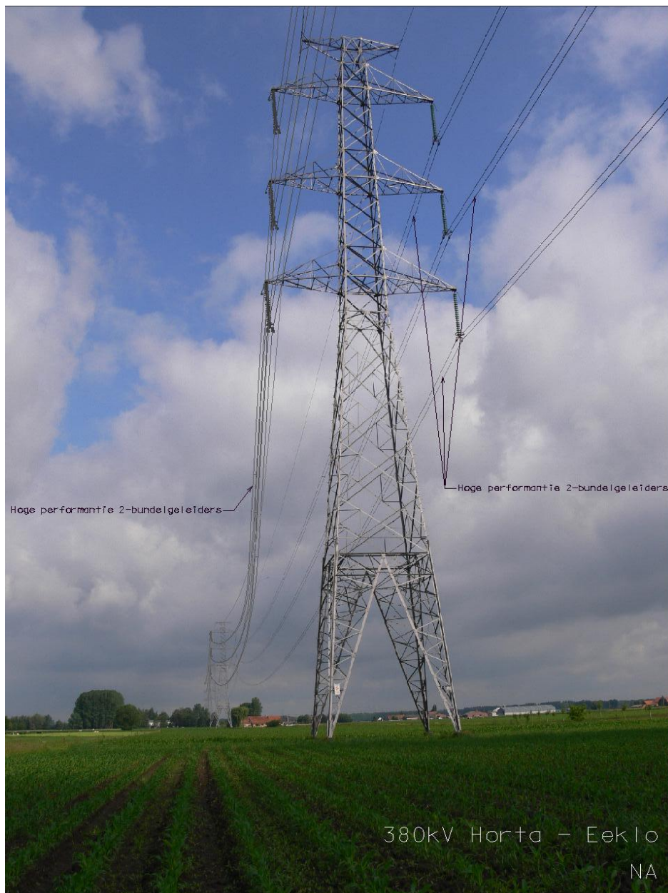
Figuur 14: Simulatie van de bovengrondse hoogspanningsverbinding met twee draadstellen
